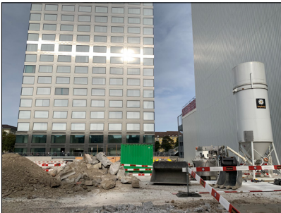
Foto: Baustelle Neubau Biomedizin
